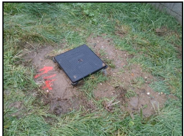
Photographie n°18 : Vue de l'ouvrage A14 après remise en état
