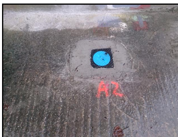
Photographie n°4 : Vue de l'ouvrage A02 après remise en état
