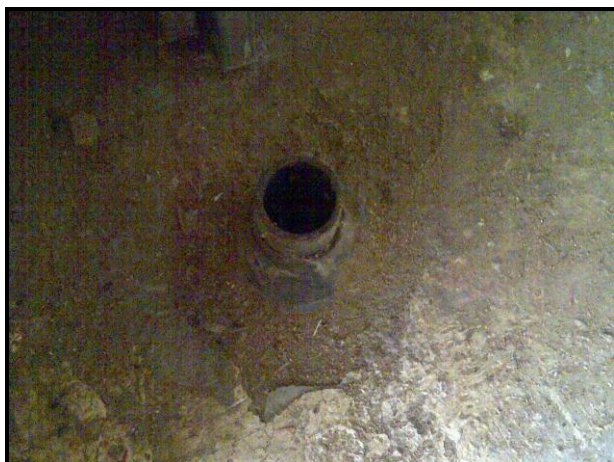
Photographie n°7 : Vue de l'ouvrage A04 avant remise en état
