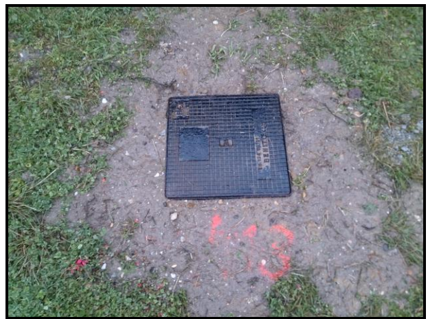
Photographie n°16 : Vue de l'ouvrage A13 après remise en état
