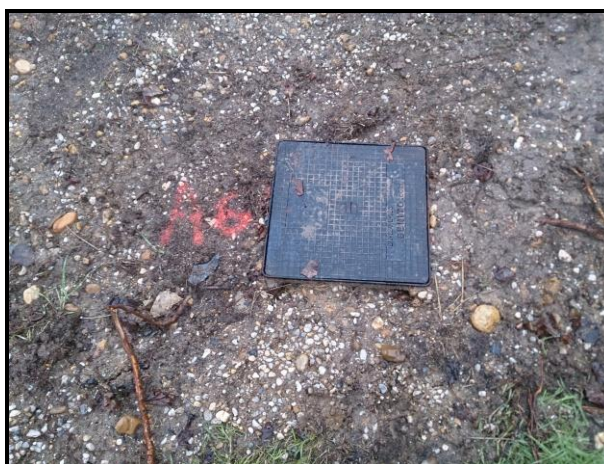
Photographie n°10 : Vue de l'ouvrage A06 après remise en état
