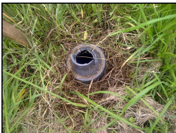
Photographie n°11 : Vue de l'ouvrage A11 avant remise en état
