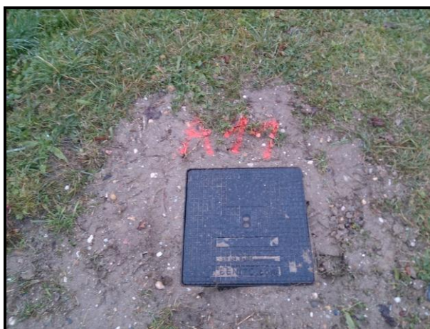
Photographie n°12 : Vue de l'ouvrage A11 après remise en état
