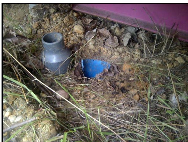
Photographie n°9 : Vue de l'ouvrage A06 avant remise en état
