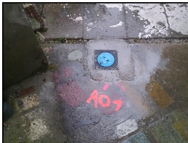
Photographie n°2 : Vue de l'ouvrage A01 après remise en état
