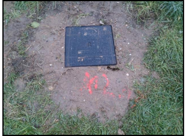
Photographie n°14 : Vue de l'ouvrage A12bis après remise en état
