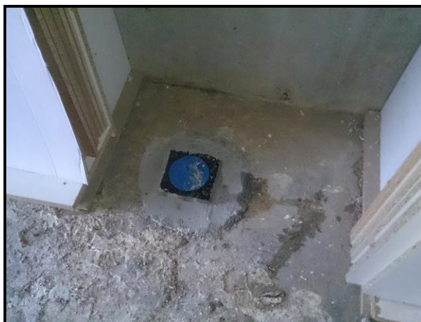
Photographie n°8 : Vue de l'ouvrage A04 après remise en état
