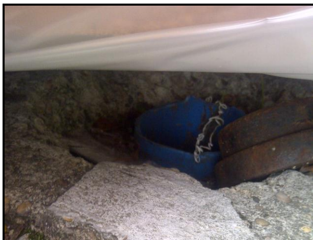
Photographie n°1 : Vue de l'ouvrage A01 avant remise en état
