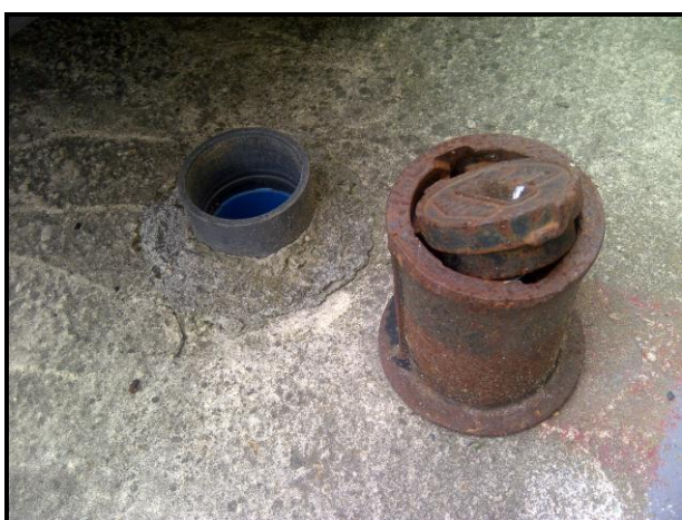
Photographie n°3 : Vue de l'ouvrage A02 avant remise en état
