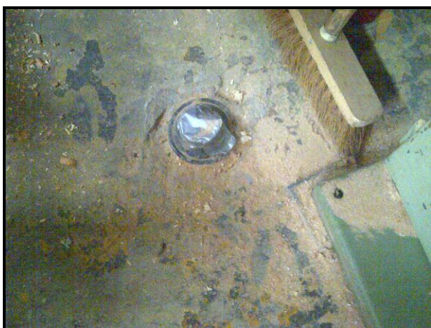
Photographie n°5 : Vue de l'ouvrage A03 avant remise en état
